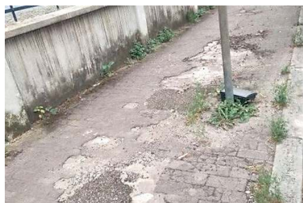
Uno dei marciapiedi di via Gaeta già oggetto di manutenzione
